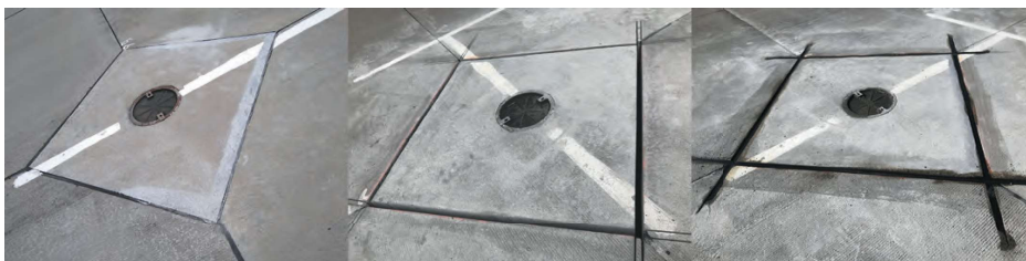
Переустройство швов в местах образования уступов
